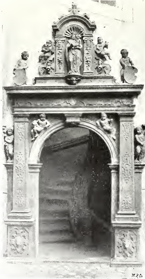
Portal und Treppenaufgang im Baseler Hof.
